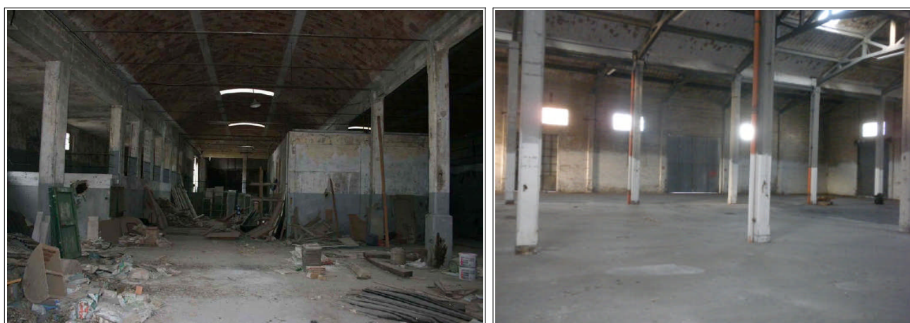
Foto 3.1 e 3.2 – Riprese degli interni dei capannoni di produzione e conservazione. La pavimentazione è dotata di solette in cls armato
